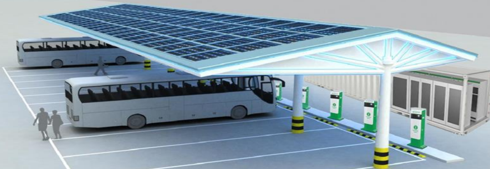
光储充一体化充电站
